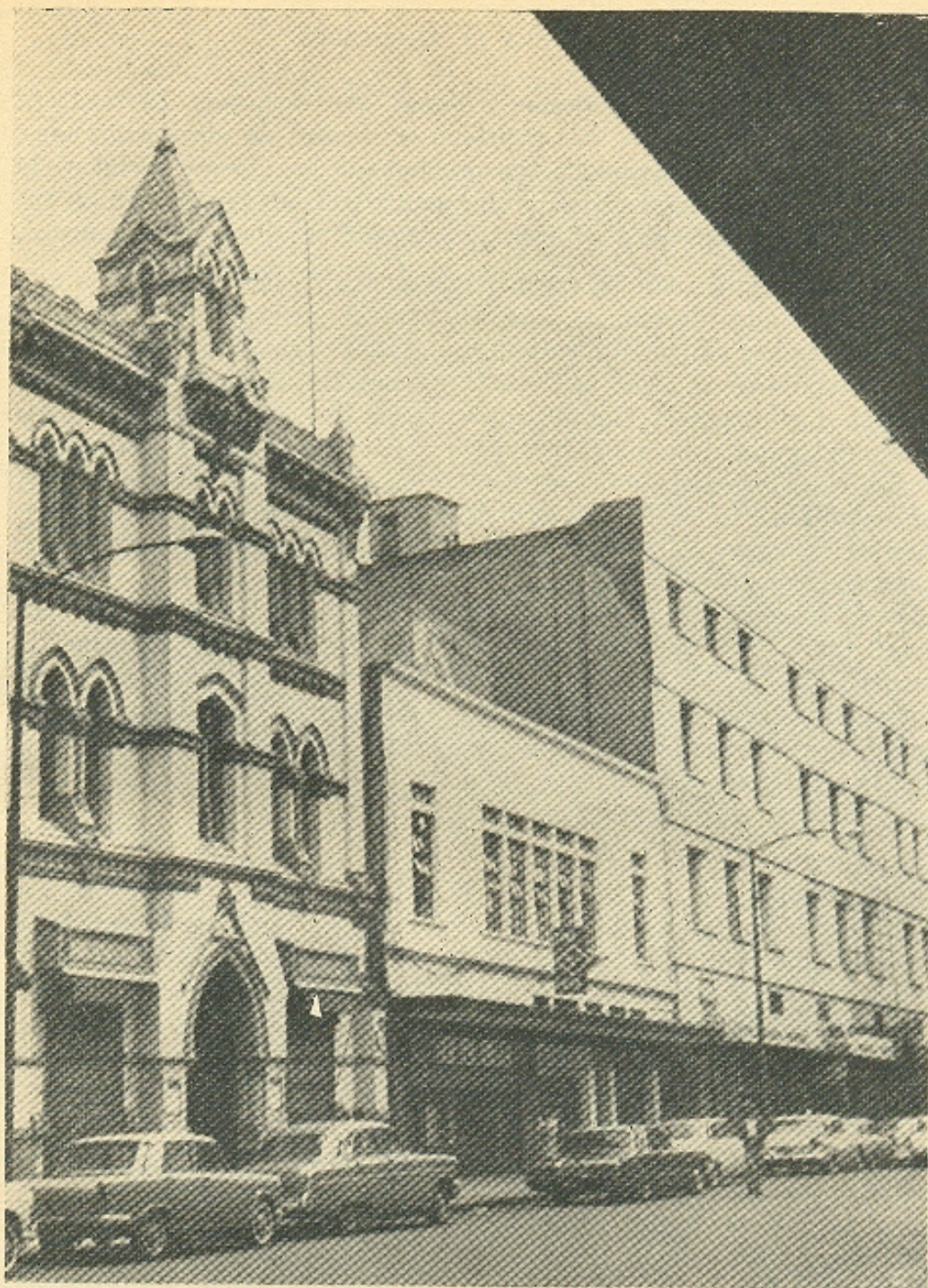
Iglesia metodista de "La Santísima Trinidad" ubicada en la primera calle de Gante número 5, local ocupado en el siglo pasado por el Gran Teatro y Circo de Chiarini, en terrenos que pertenecieran al convento de San Francisco. En el viejo Circo Chiarini, tuvo también residencia transitoria la H. Cámara de Diputados los días del 17 de septiembre al 30 de noviembre de 1872, antes de su traslado definitivo al local que ahora ocupa.
