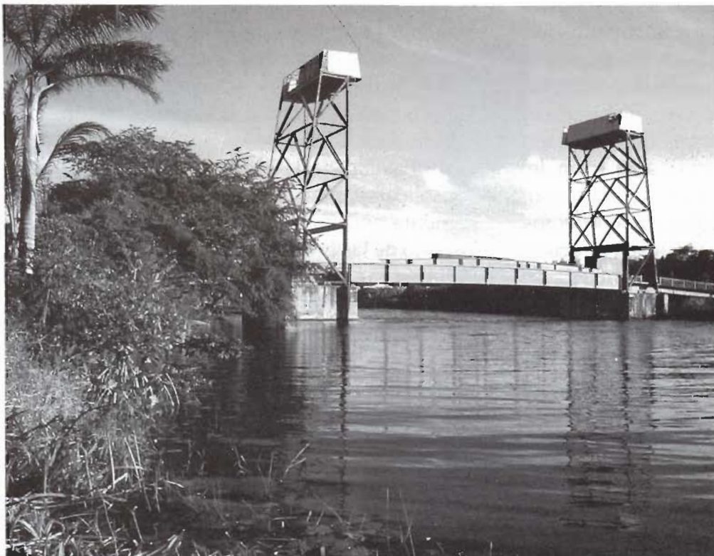
Puente Internacional sobre el río Hondo, frontera de México con Belice
