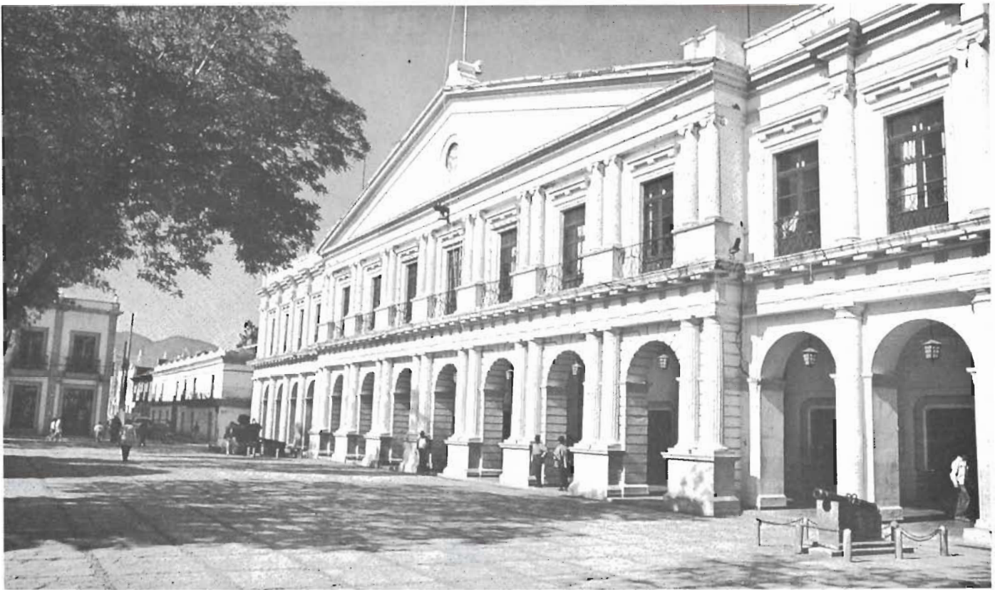
Palacio Municipal de San Cristóbal de las Casas.
