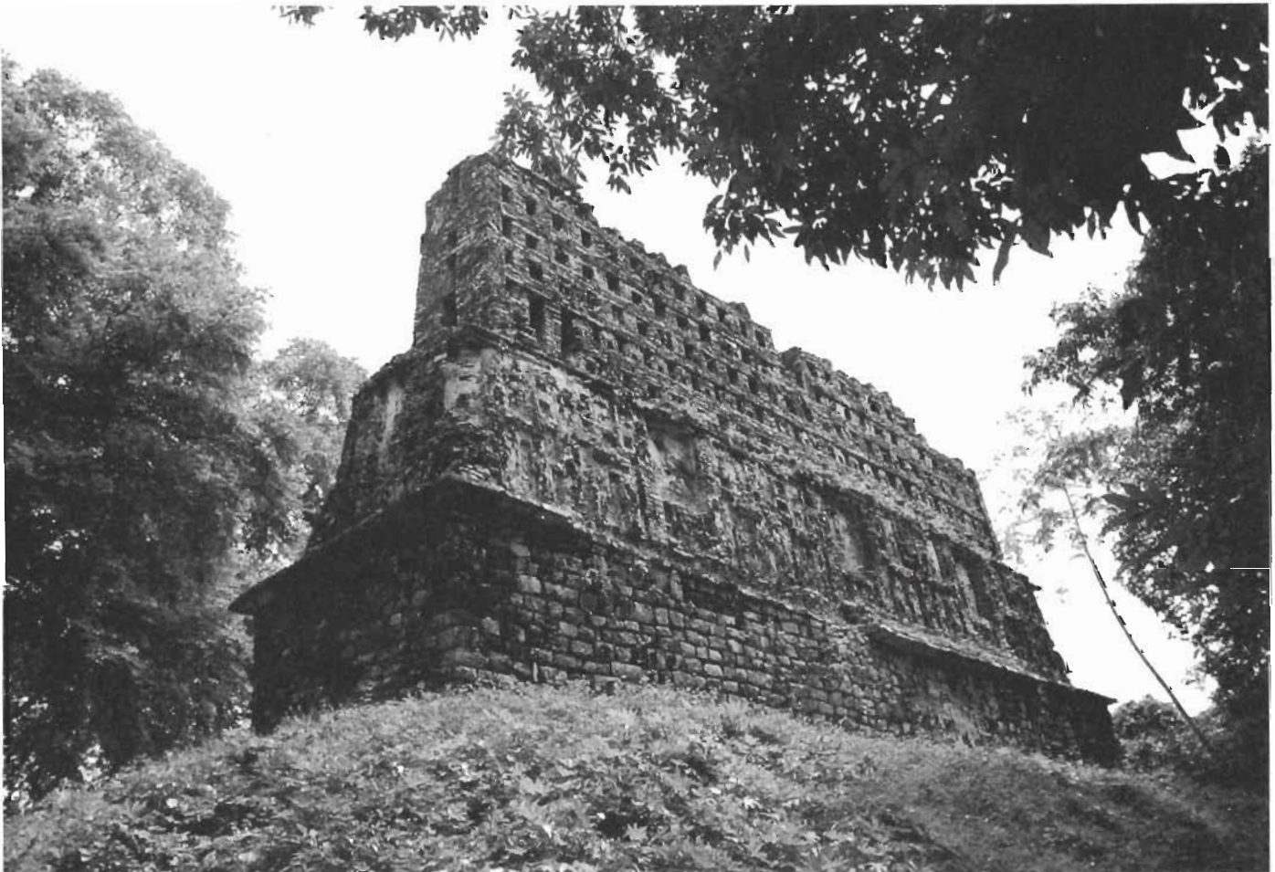
El Edificio 33, el más importante de Yaxchitlán.
