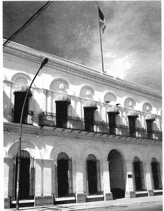
Edificio de la Procuraduría de Justicia del Estado de Sinaloa
