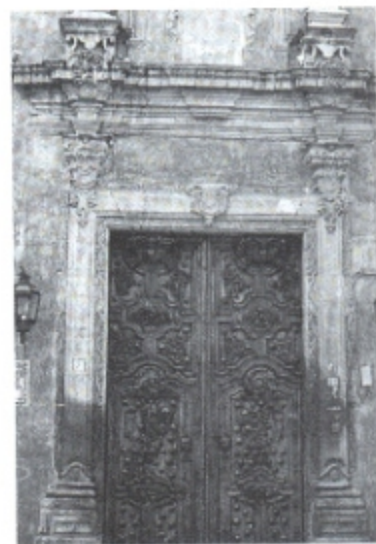
Detalle Portón de la Casa de La Marquesa
