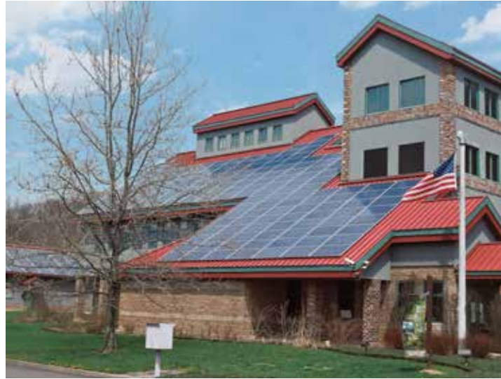
Figura 19 Celdas solares para proveer electricidad a un edificio
