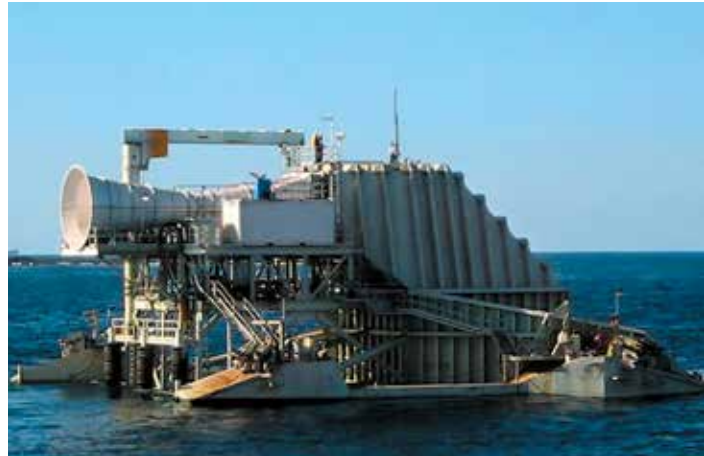
Figura 47 Diagrama esquemático de un dispositivo de columna oscilante de agua
