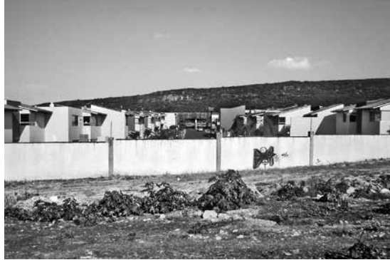
Vista desde rambla central. Al fondo reserva del tángano. Fuente: EDC.
