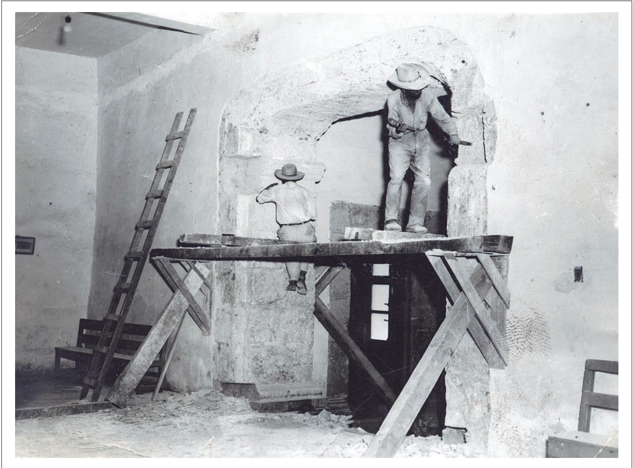
Obras de restauración del edificio del Museo Michoacano, 1938. (AH-UM).
