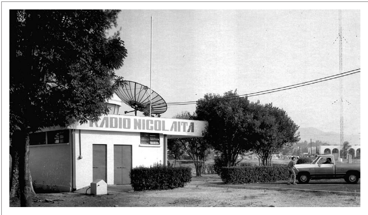
Edificio de la Radio Nicolaita, (AF-IIH).
