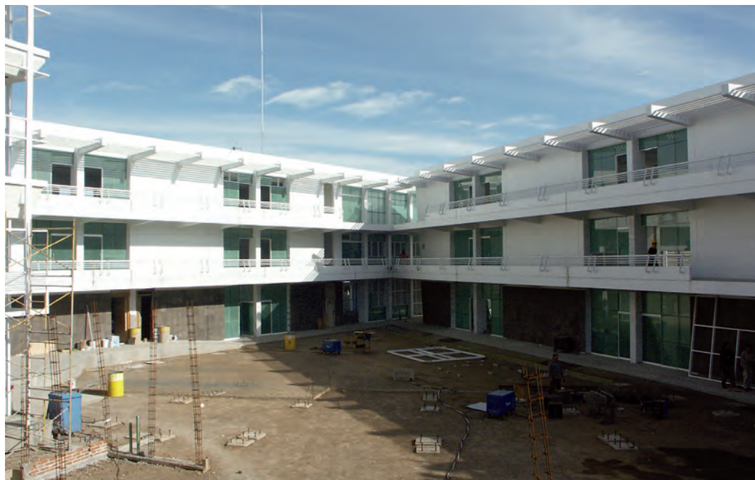
Imagen interior del edificio de la Facultad de Arquitectura, 2001 (AFLSB).
