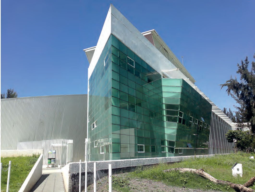
Imagen del edificio de la Facultad de Arquitectura (AFLSB).
