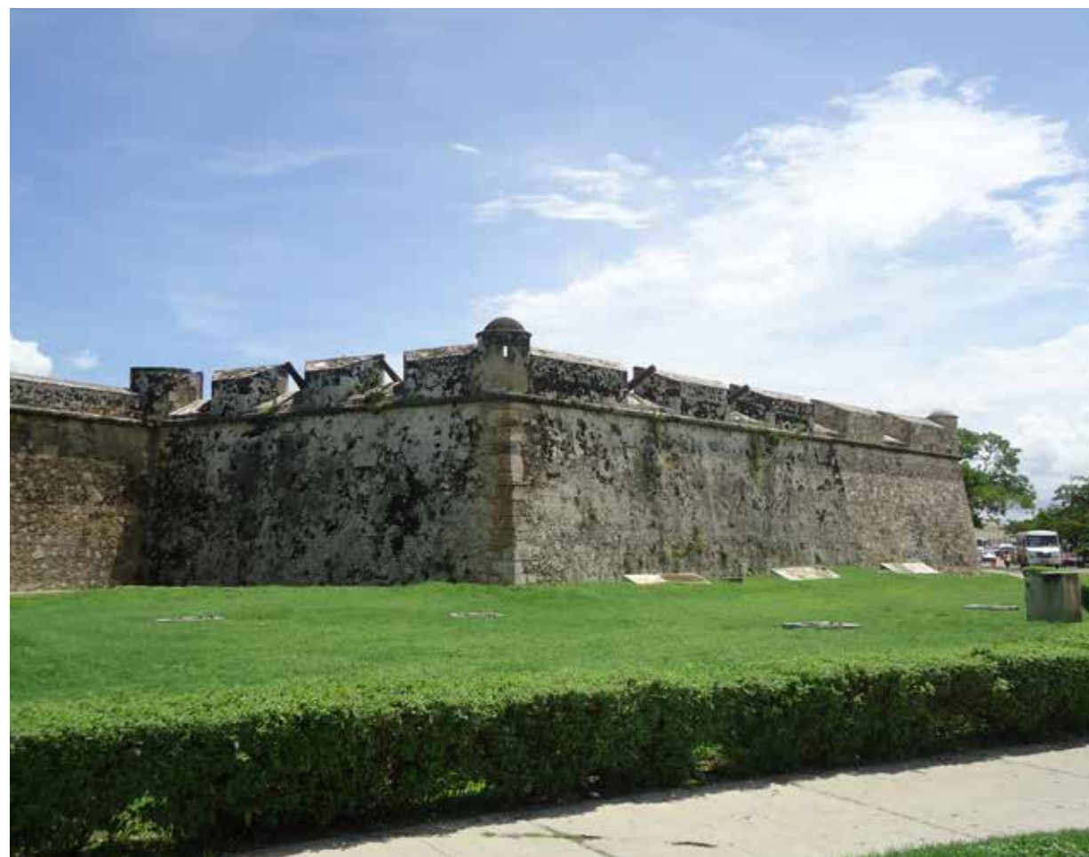
Fig. 34. Estado actual del Baluarte de San Francisco.
