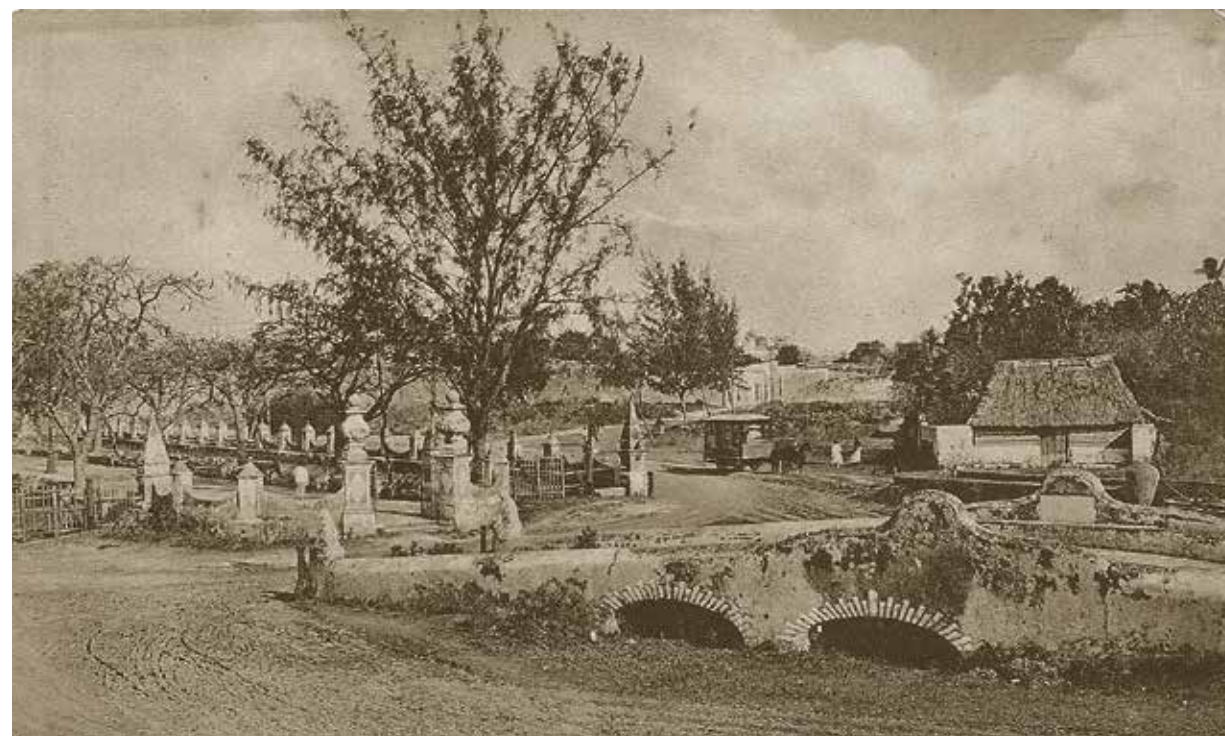
Fig. 7. Puente de los Perros, en la Alameda.
