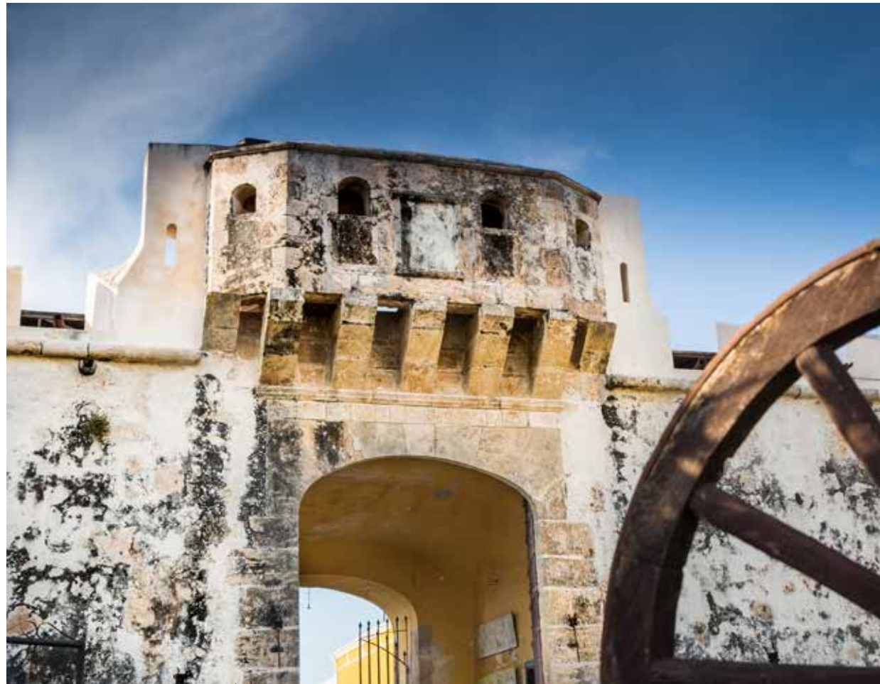
Fig. 43. Vista de la caspa o saratana de la Puerta de Tierra.
