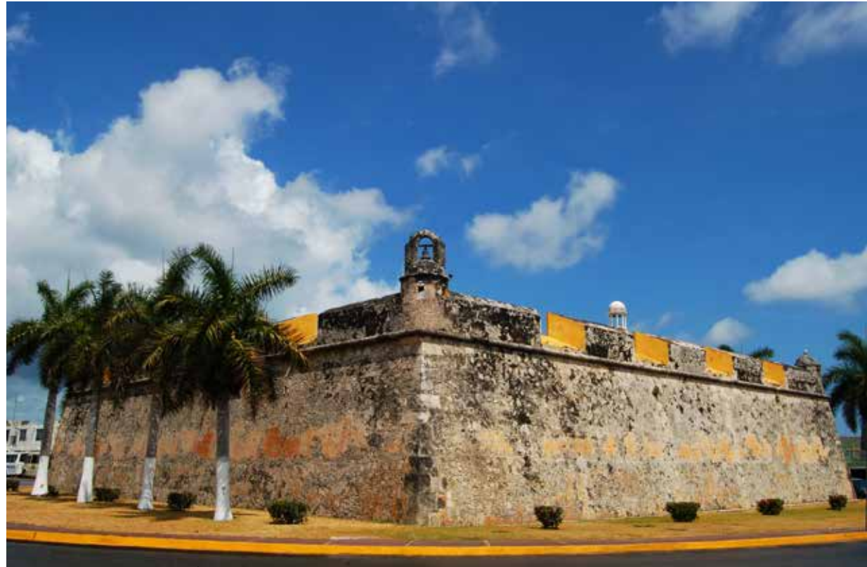
Fig. 35. Estado actual del Baluarte de San Pedro.
