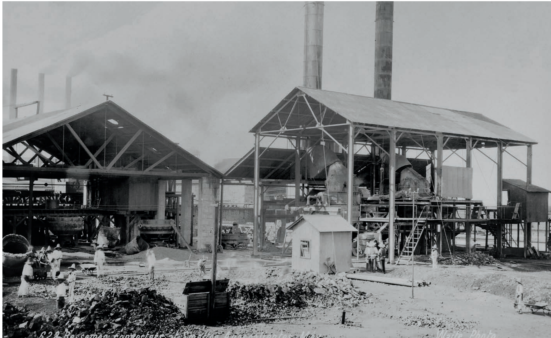
Trabajadores en la fundición de acero en Aguascalientes, ca. 1905. Fotografía Charles B. Waite. AGN.
