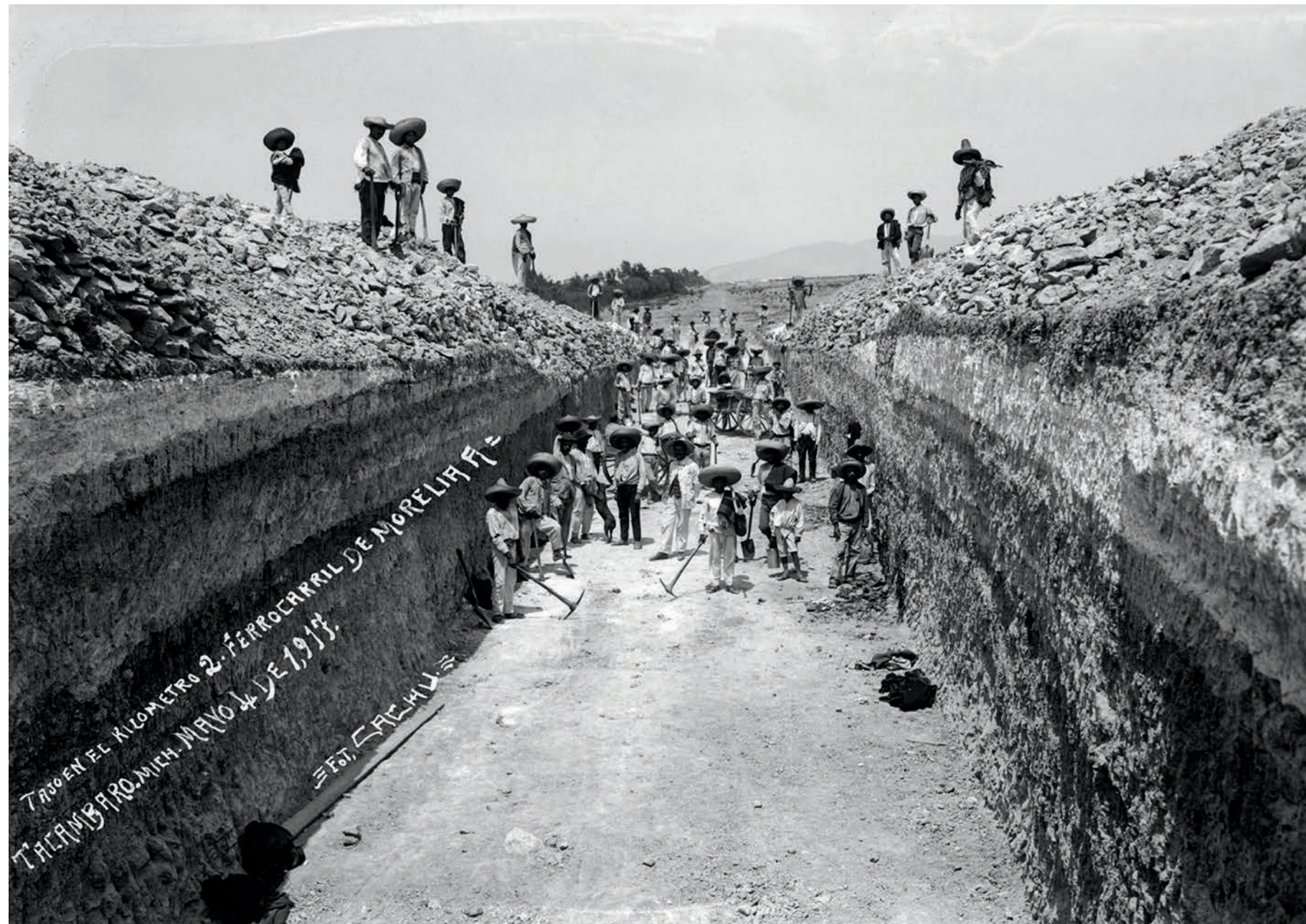
Tajo en el kilómetro 2, ferrocarril de Morelia a Tacámbaro, Michoacán, México, ca. 1917. Fotografía Juan Cachú Ramírez.
