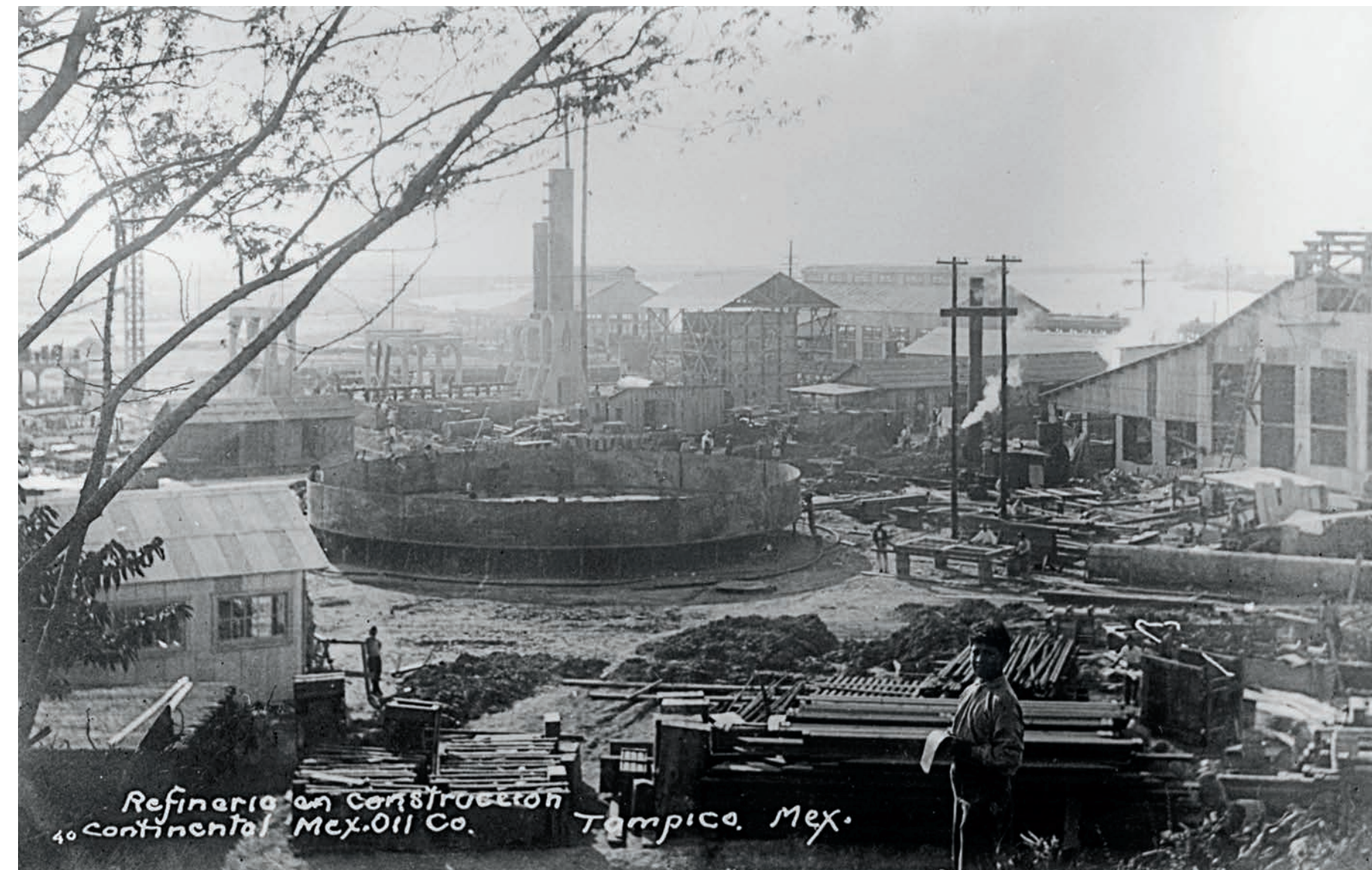
Refinería de la Continental Mexican Oil, Co., en construcción, Tampico, México, ca. 1921. Anónimo. Colección particular.
