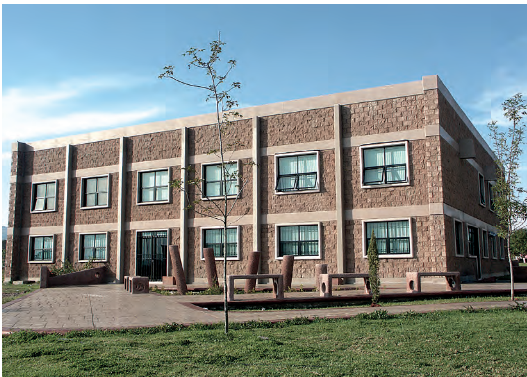
Edificio de posgrado de la Facultad de Ingeniería Civil, 2002 (AFLSB).
