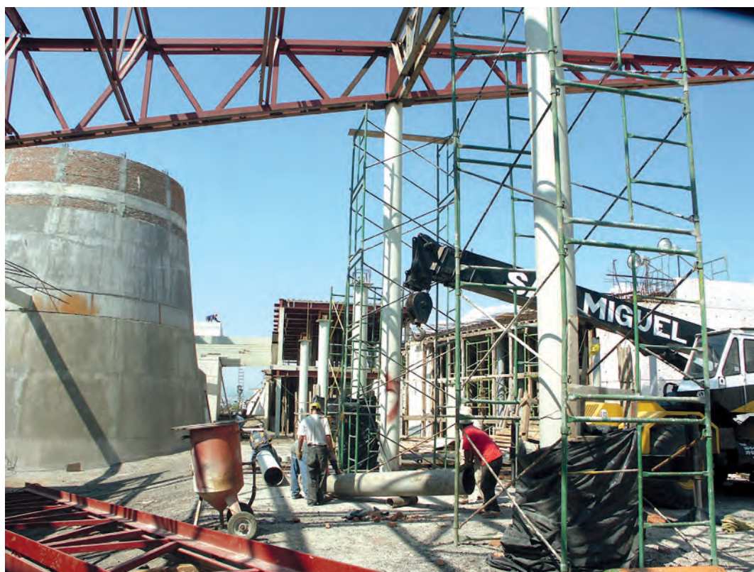
Imagen del edificio en construcción del CIAC, 2000 (AFLSB).
