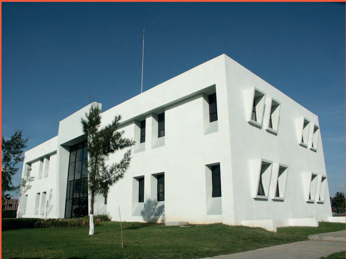
Superior: Toma aérea de Ciudad Universitaria, 2002 (AFLSB). Inferior: Imagen del edificio del Instituto de Investigaciones Históricas, 2002 (AFLSB).
