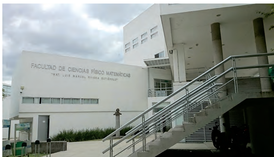
Imagen del Edificio de la Facultad de Físico-Matemáticas, 2017 (AFLSB).
