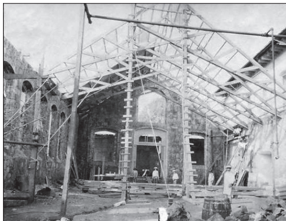
Fábrica San Pedro en construcción (1894)
