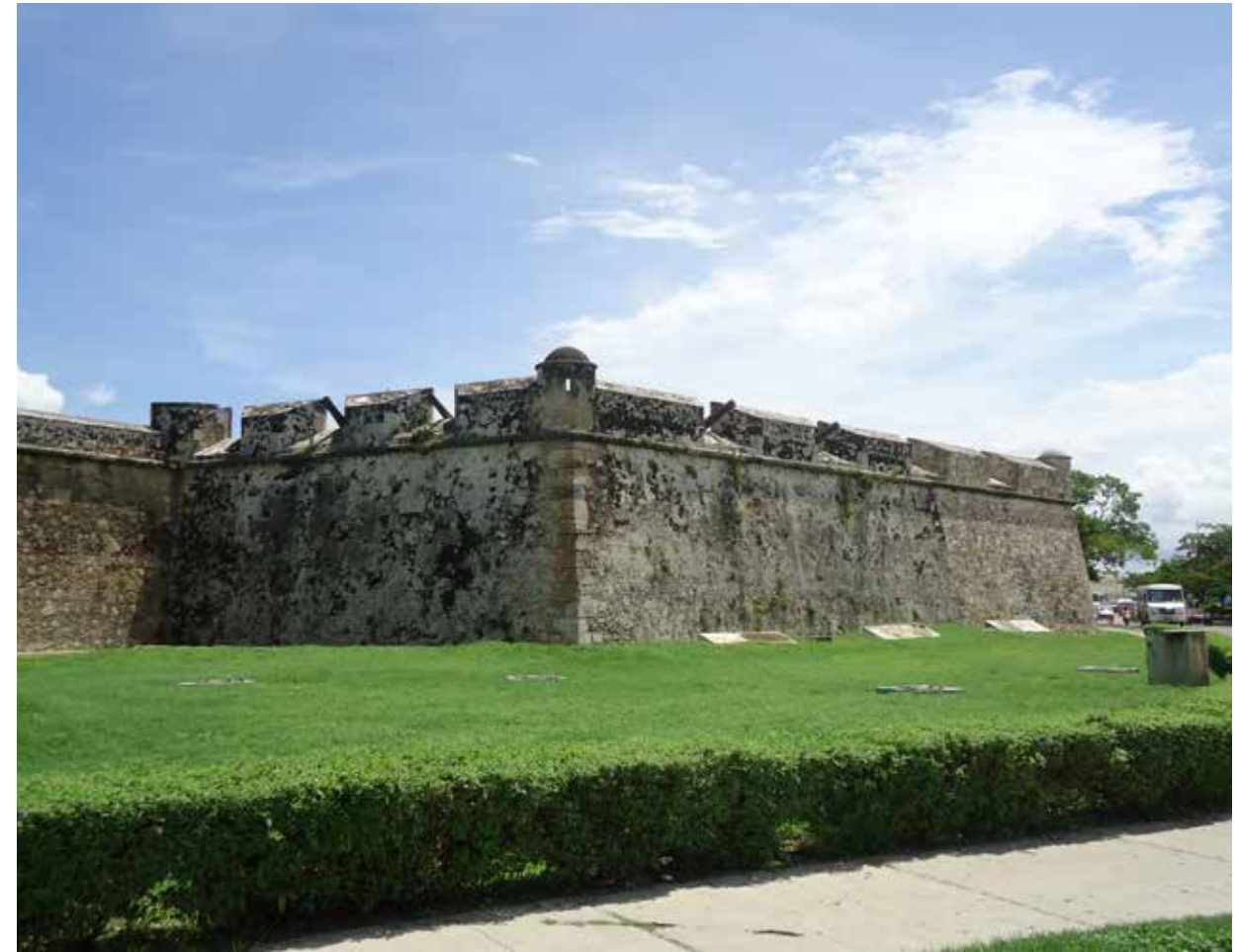
Fig. 34. Estado actual del Baluarte de San Francisco.
