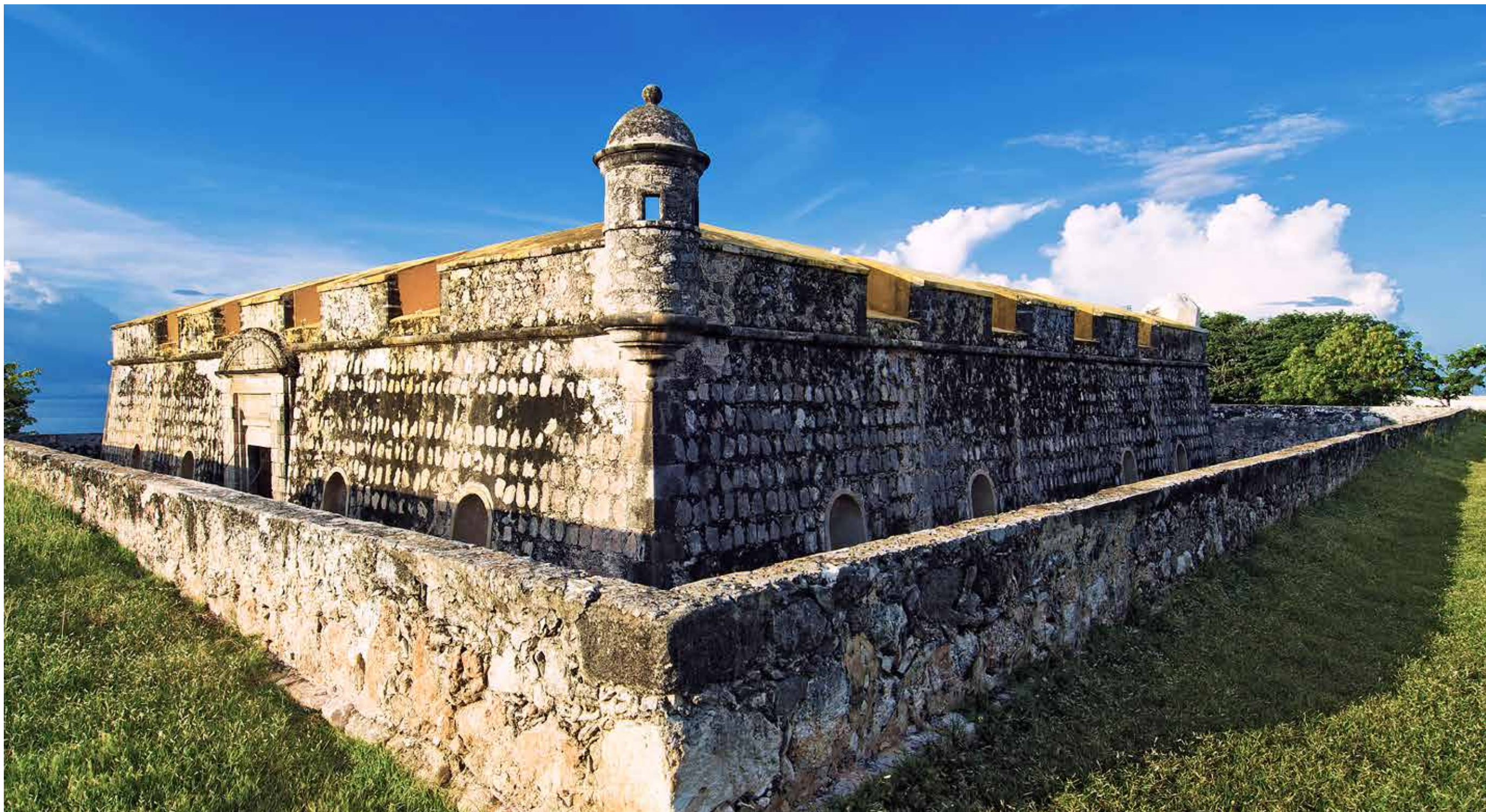
Fig. 56. Vista actual del Fuerte de San José El Alto.
