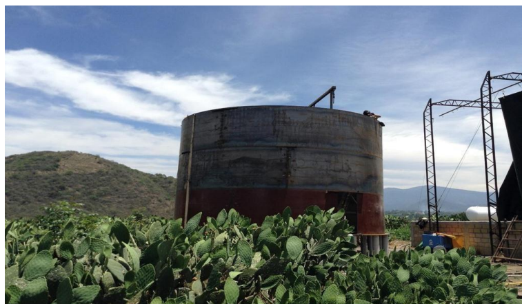
Avance de la construcción del Biodigestor al 30 de abril de 2016. Segundo Biodigestor Fuente Nopalimex
