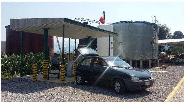
Puesta en marcha del segundo biodigestor y de la estación despachadora de biogás, tanque de almacenamiento y compresor que surte de biogás al vehículo. Foto: Nopalimex
