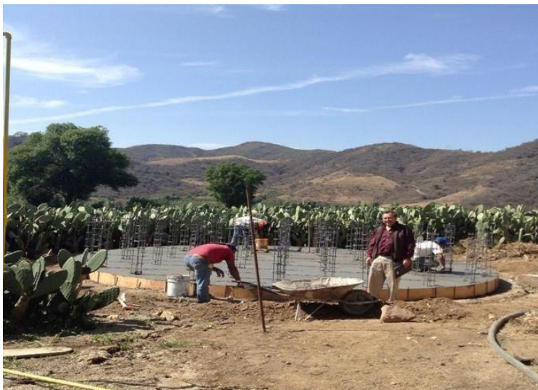
Inicio de la construcción del segundo biodigestor, el 1° de marzo de 2016, construcción de la obra civil, cemento y pilotes del biodigestor. Zitácuaro, Michoacán Fuente: Nopalimex
