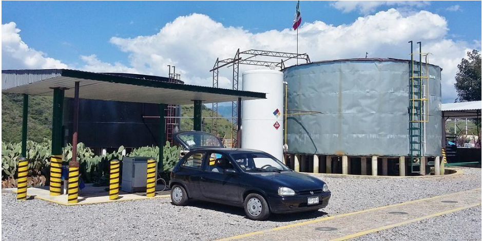
Vista actual de la Planta agroindustrial de generación de biogás. Vehículo cargando biogás de nopal. Zitácuaro, Michoacán. Fuente: Nopalimex
