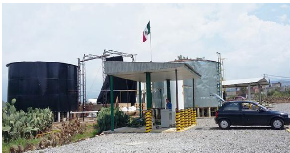
Esta fotografía muestra una vista lateral de la planta, al fondo los dos biodigestores. En primer plano la estación despachadora de biogás para vehículos. Zitácuaro, Michoacán, 2016. Foto: Nopalimex.
