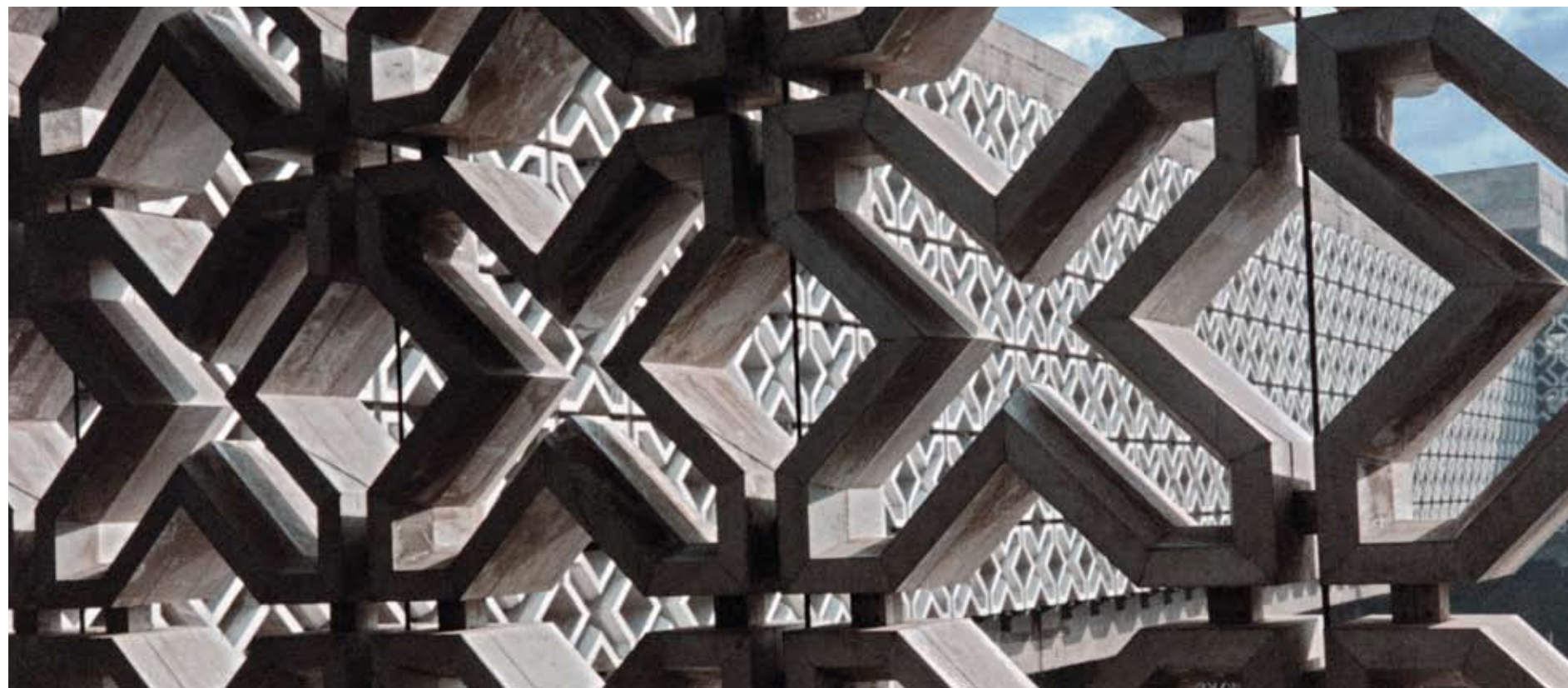
Detalle de la celosía en aluminio del patio principal.
