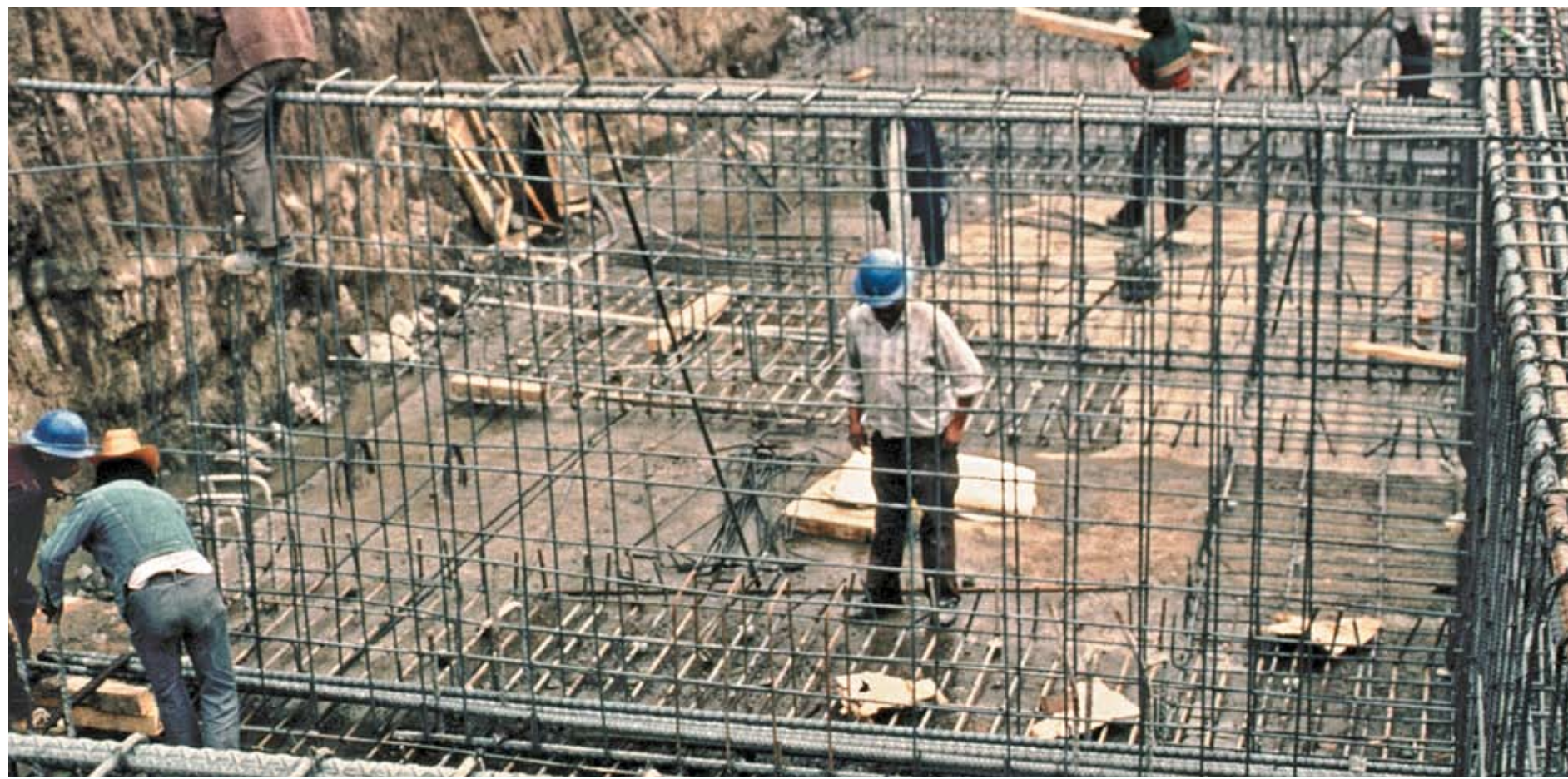
Armado de muros y columnas.
