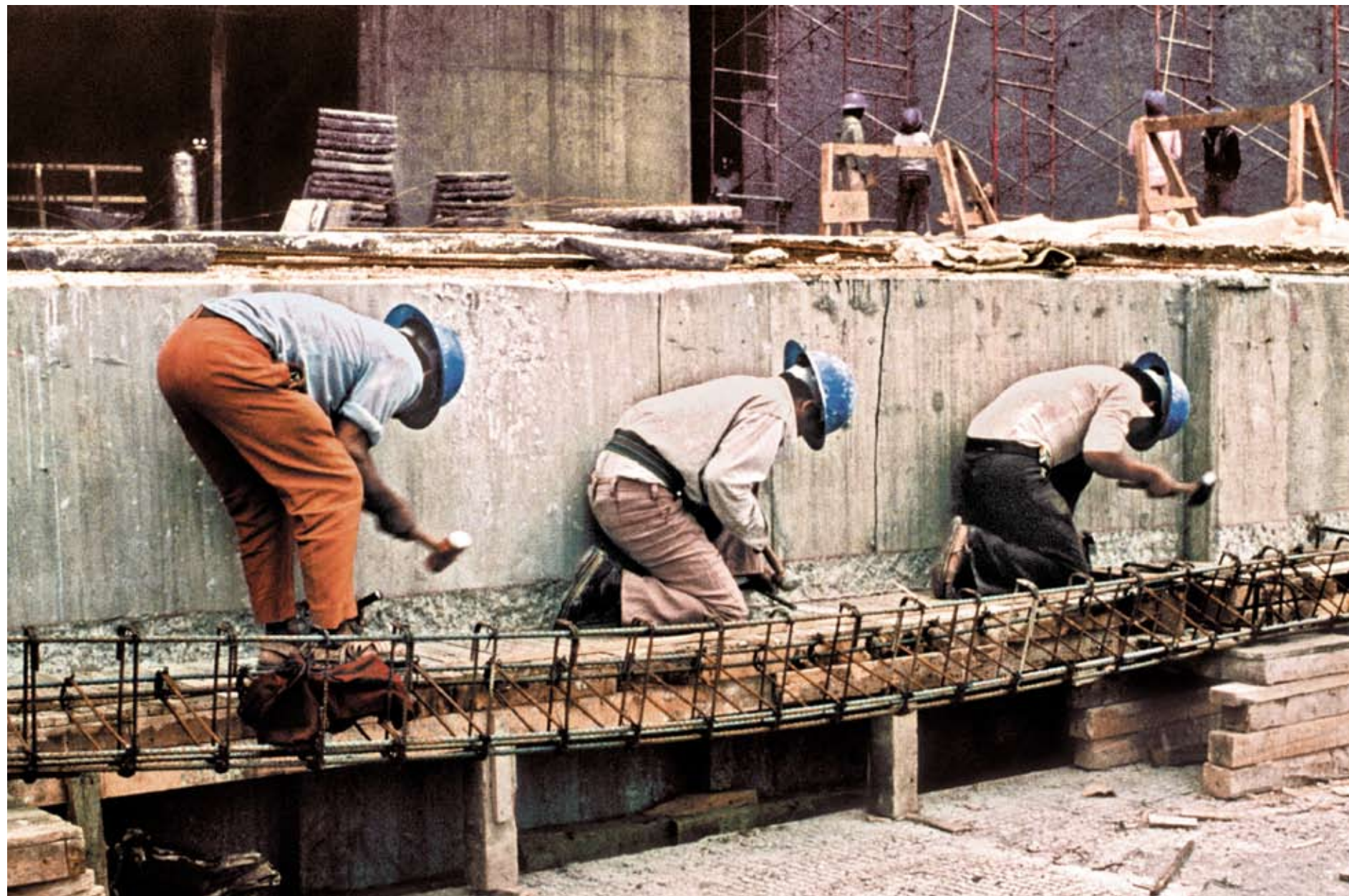
Martelinado del concreto armado.
