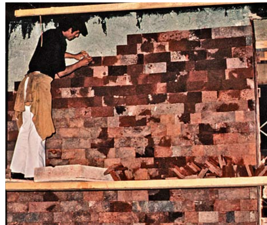
Acabados de madera de cedro en los muros y palcos, y colocación de piezas de tezontle.
