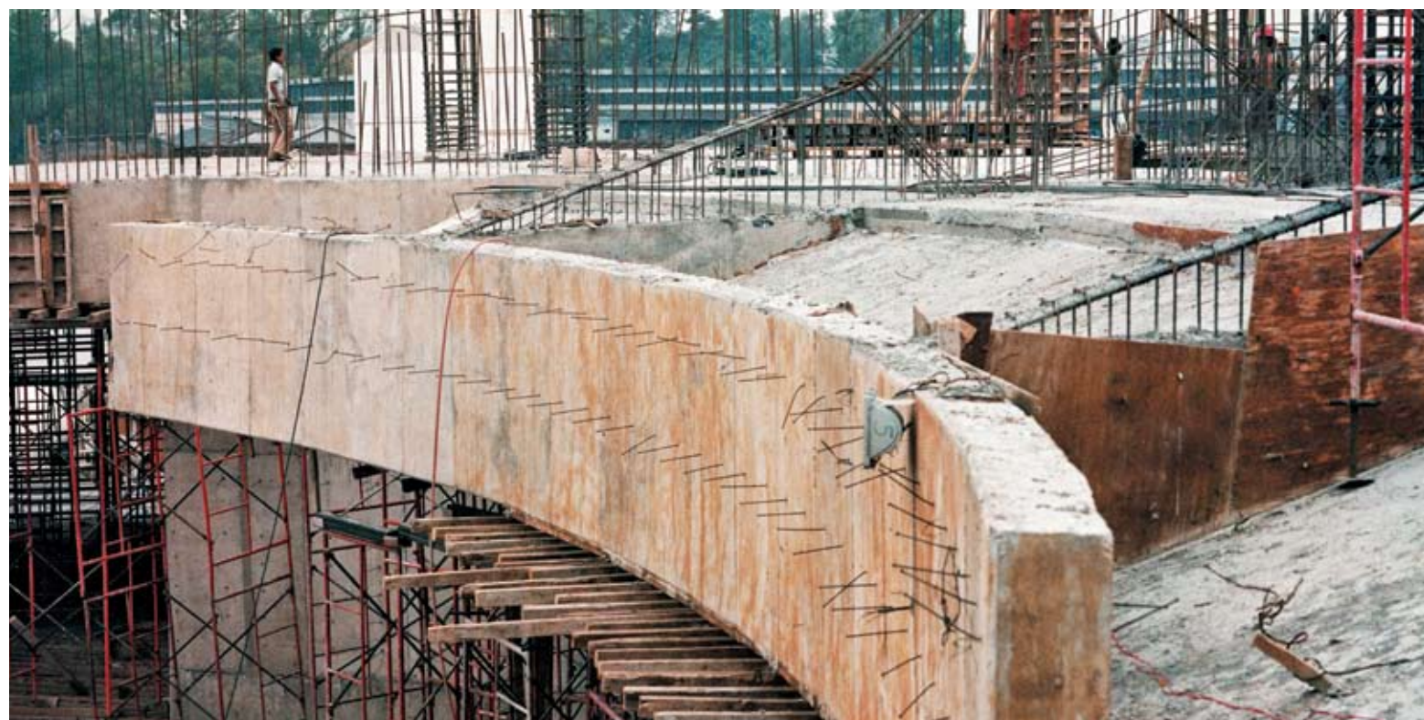
Detalles de construcción en la galería del Salón de Sesiones.
