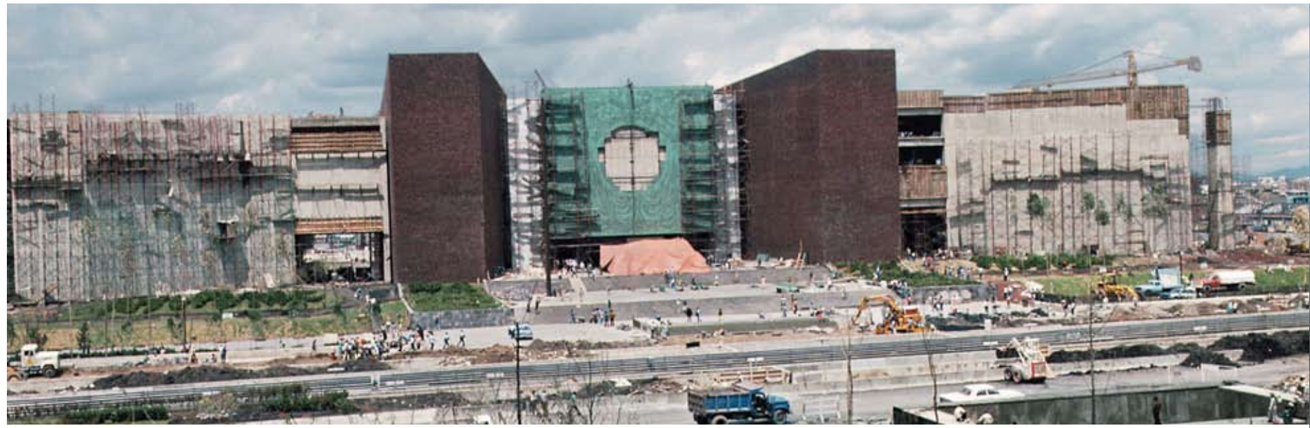
Distintos aspectos de la colocación del Escudo Nacional sobre la fachada principal.
