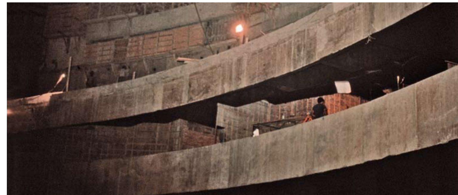
Faldón en pablos y galerías antes de acabados.
