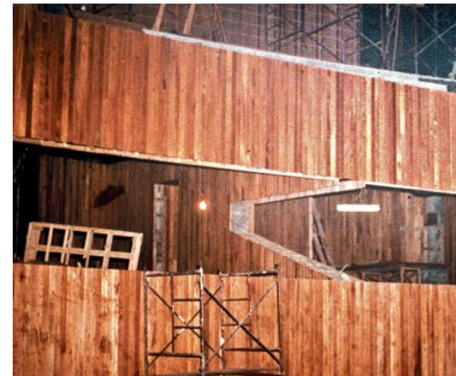
Acabados de madera de cedro en los muros y palcos, y colocación de piezas de tezontle.
