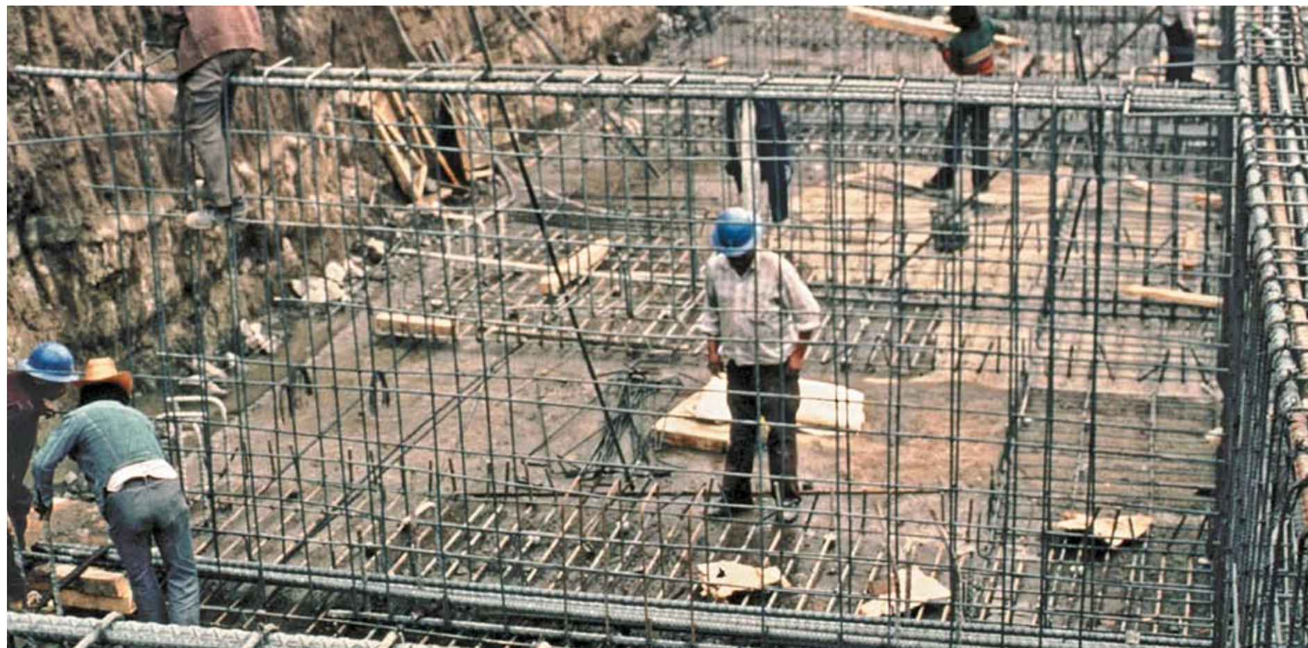
Armado de muros y columnas.
