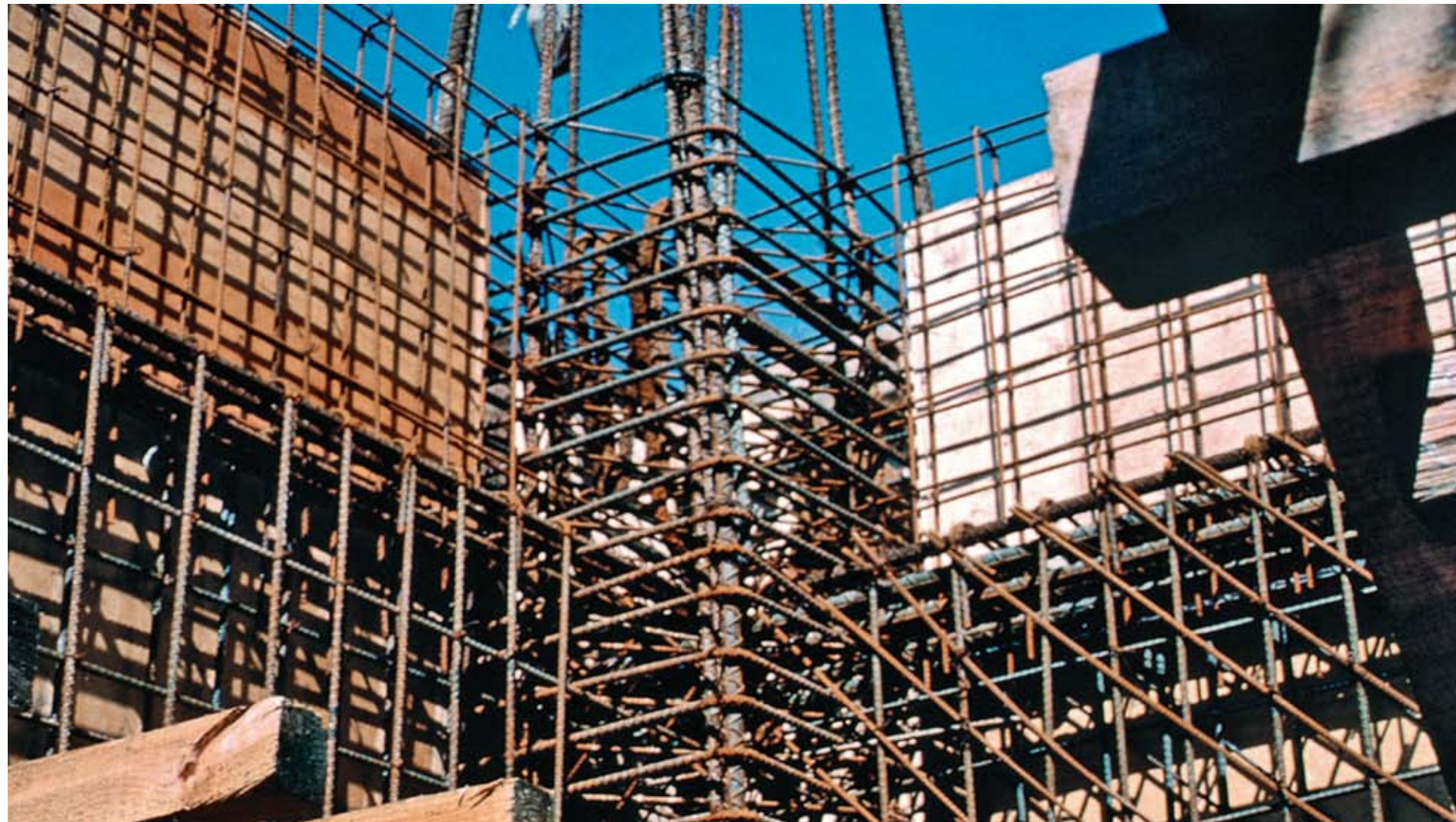
Armado de muros y columnas.
