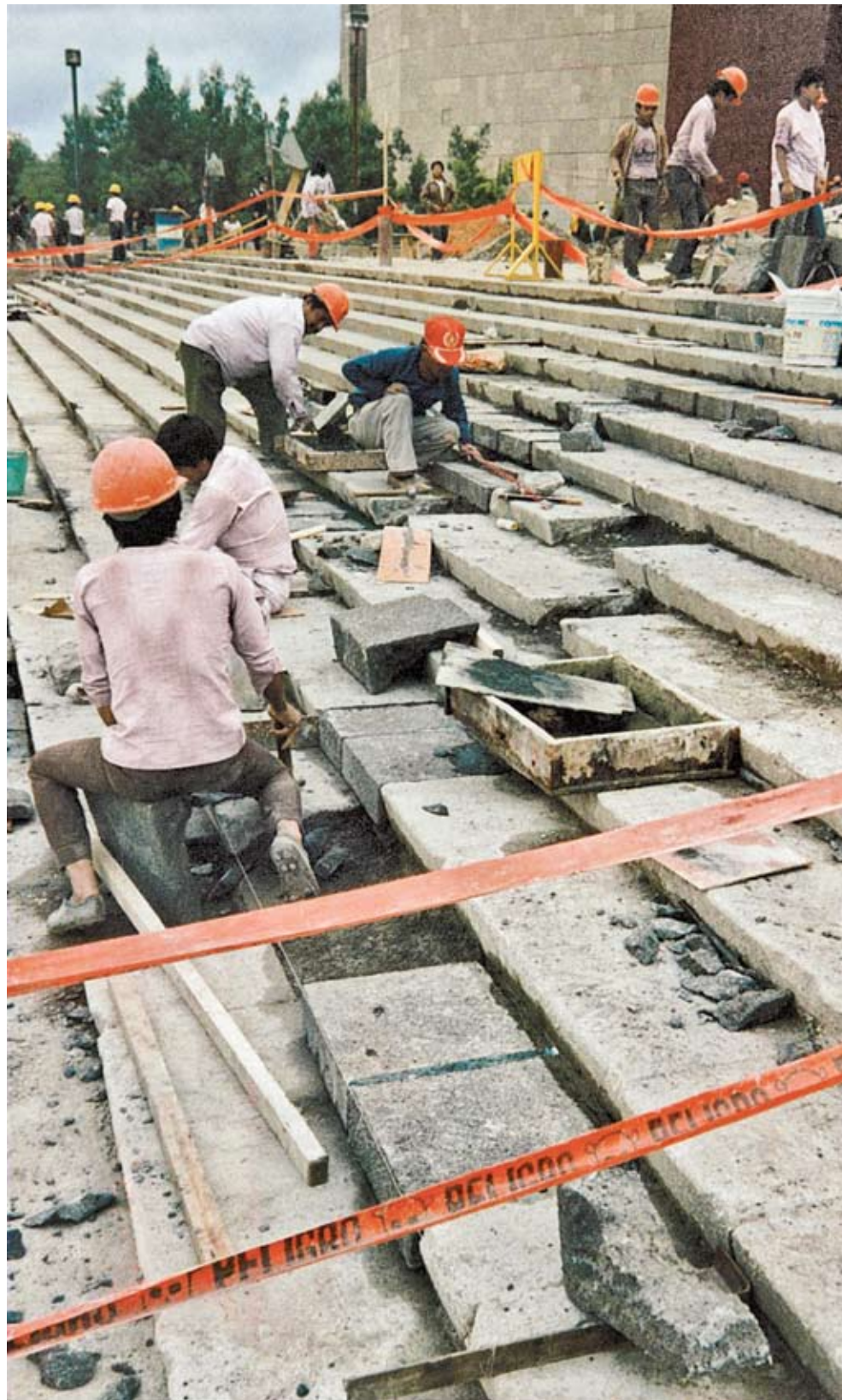
Trabajos de restauración en la escalinata de acceso.
