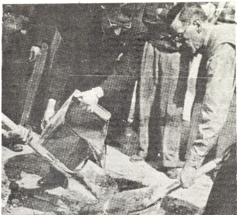
Wilfrido Massieu (a la derecha) inicia él mismo los trabajos de construcción del histórico cuadrilátero de Santo Tomás.
