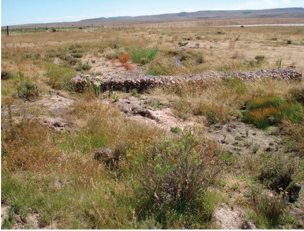
Figura 4. Presas filtrantes para manejo de escorrentías y conservación de suelos en MIRZA Viboritas, Gpe., Zac., 2007
