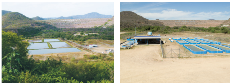
Infraestructura del Centro de Reproducción de Peces.
