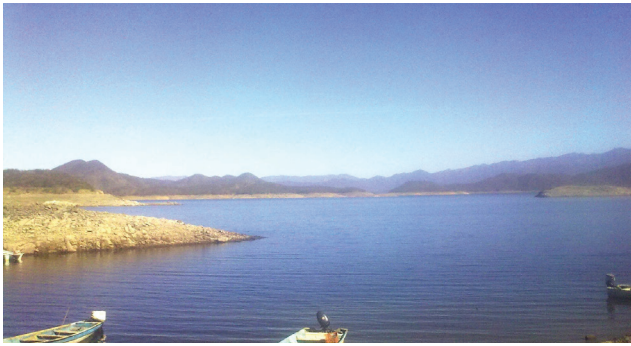
Panorámica de la cortina de la presa.
