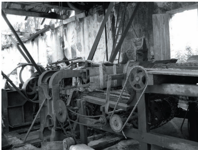
Foto 2. Diferentes aspectos de la maquinaria de la desfibradora de principios del siglo XX, que aún funciona en la Hacienda de "San Lorenzo" o "Ruinas de Ake", 2008.
