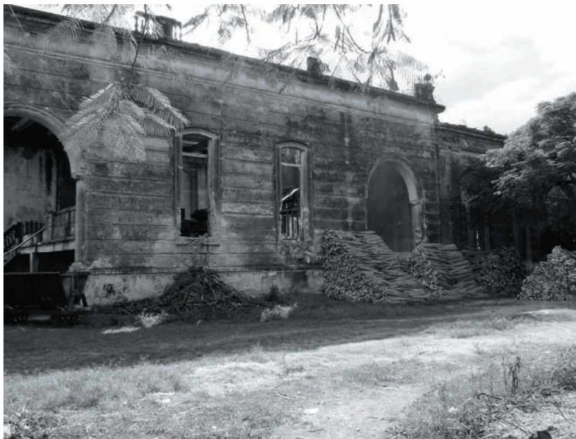
Sala de máquinas de la Hacienda "Ruinas de Ake". 2008.
