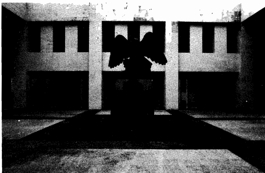
Patio Central del recinto oficial
