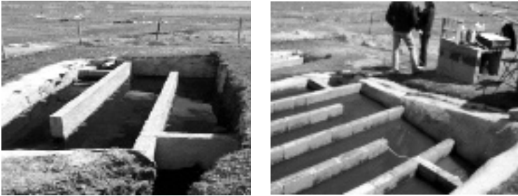
FIGURA I PRIMERO Y SEGUNDO CONJUNTO DE SISTEMAS LAGUNARES. ESQUEMA DE MAMPARAS
