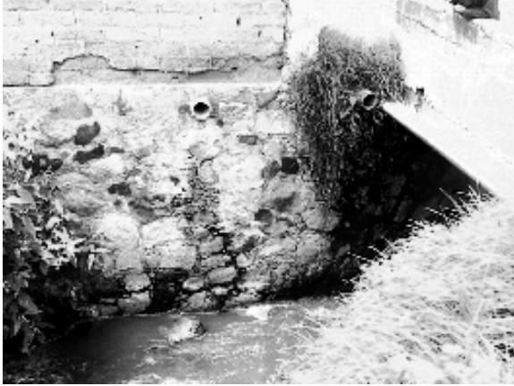
FIGURA 2 DESCARGAS DIRECTAS DE AGUAS RESIDUALES DOMÉSTICAS AL RÍO
