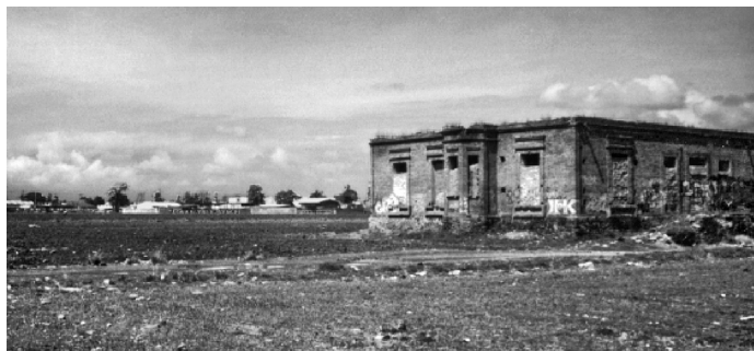
Restos de un antiguo casco de hacienda rodeada de tierras de cultivo, localizado en el Barrio La Conchita, frente al antiguo rastro municipal. Foto: Jaime Linares Zarco, 2004.
