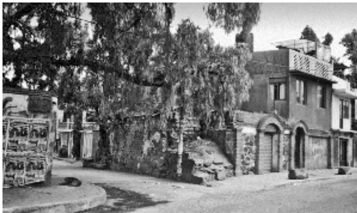
Antigua casa abandonada con muros de adobe y piedra de un solo nivel, al lado de una moderna casa con muros de tabique, piso y techo de cemento con dos niveles en la calle Hidalgo, Barrio San Lorenzo. Foto: Jaime Linares Zarco, 2004.
