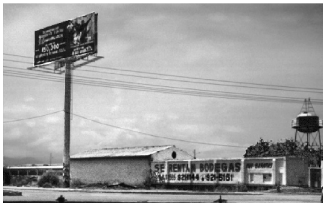
Antiguas instalaciones de la fábrica de huevo Garcés, cuyo anuncio comercial aún se distingue en lo alto del tinaco, sobre la carretera México- Texcoco, cerca de Cuautlalpan frente a la plaza comercial Puerta Texcoco.
