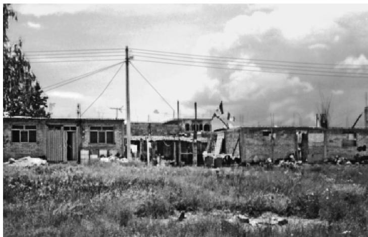
Nueva colonia popular (Margarita Morán), que se inició en 1995 como una invasión irregular promovida por Antorcha Popular, integrada por 600 viviendas autoconstruidas, junto al complejo habitacional "Cuatro Vientos". Foto: Jaime Linares Zarco, 2004.
