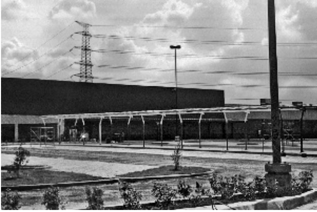
Construcción de una nueva Bodega Aurrerá sobre el terreno de una antigua fábrica de concretos y premezclados en el Valle de Los Reyes.
