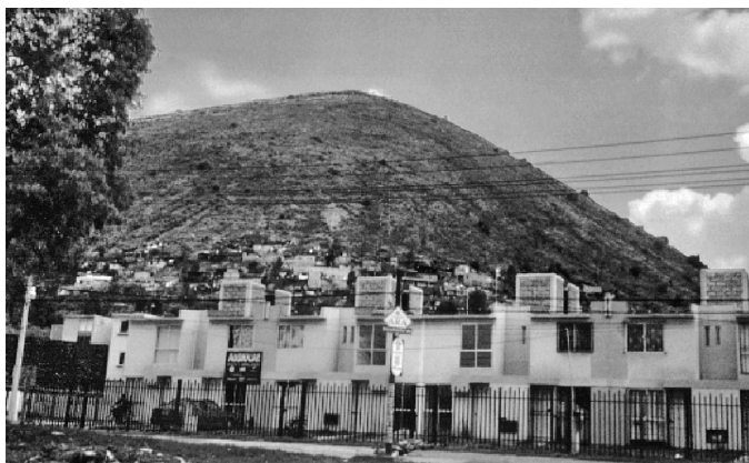
Conjunto habitacional Valle de Los Pinos construido sobre las faldas del cerro El Pino, en la carretera federal México-Puebla.
