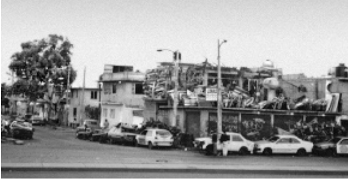
Casa particular con locales comerciales saturados e improvisados como negocios de compra-venta de chatarra sobre la calle 7 y 4a. avenida, Colonia Estado de México. Nótese la invasión de las banquetas y del arroyo vehicular. Foto: Jaime Linares Zarco, 2004.
