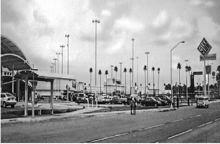
Plaza Comercial Sendero, en donde se ubican: Soriana, Woolworh, Suburbia y otras más. Edificada por Inmobiliaria Desarrolladora Río Tijuana, S.A. de C.V. entre mayo y diciembre de 2005, sobre un terreno de 40 hectáreas, que antes fue una granja de avestruces. Foto: Jaime Linares Zarco, 2007.
