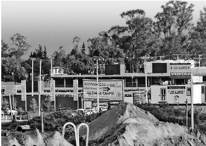
Conjunto Residencial “Los Álamos”, localizada en el km 41.5 sobre la carretera México-Cuautla, en San Gregorio Cuautzingo, en lo que fuera el Rancho Santa María Atoyac, en donde el grupo Procsa/Sadasi edificó 3,552 viviendas desde mayo de 2004. Foto: Víctor Hugo Ramos Acevedo, 2005.
