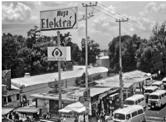
Antiguas instalaciones donde se localizaba Ayotla Textil (1947-1982), la cual, después de su cierre y liquidación, fue demolida, hasta vender parte de su terreno a las empresas Elektra y al grupo Wal Mart.
