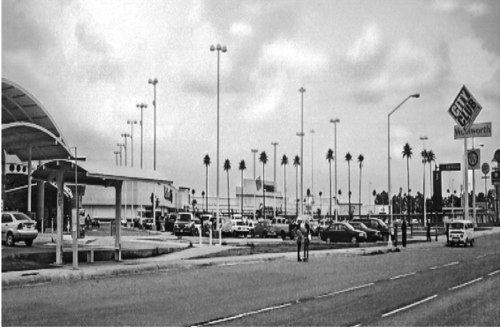
Plaza Comercial Sendero, en donde se ubican: Soriana, Woolworh, Suburbia y otras más. Edificada por Inmobiliaria Desarrolladora Río Tijuana, S.A. de C.V. entre mayo y diciembre de 2005, sobre un terreno de 40 hectáreas, que antes fue una granja de avestruces.
