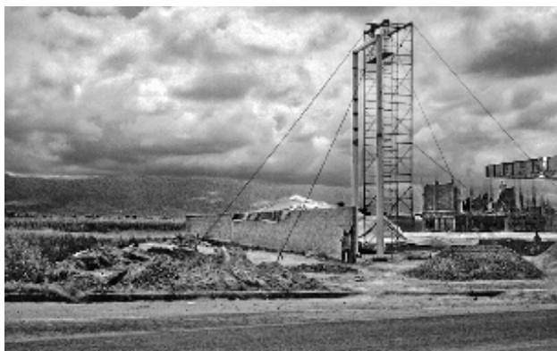
Construcción de una nueva gasolinería localizada en la carretera Chalco-Cuautla, sobre tierras de cultivo. Cabe señalar que entre 2002 y 2004 se autorizaron doce nuevas gasolinerías en el municipio. Foto: Jaime Linares Zarco, 2004.
