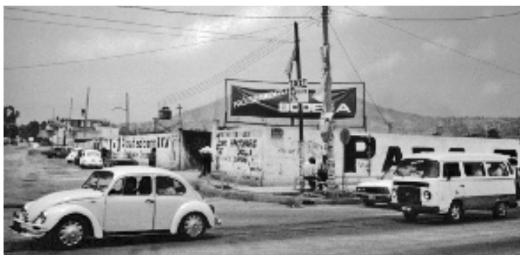
Construcción de una nueva Bodega Aurrerá sobre tierras de cultivo en la Avenida Nezahualcóyotl, colonia Guadalupe, frente al Rancho Piedras Negras. Foto: Jaime Linares Zarco, 2004.
