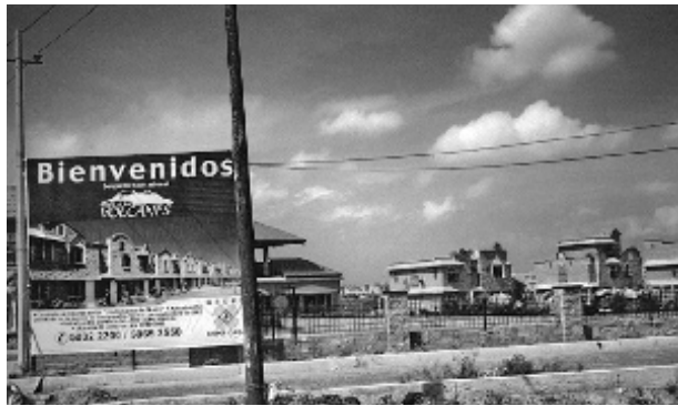
Conjunto Habitacional “Los Volcanes”, sobre la salida hacia Ayotzingo, donde el Grupo Expocasa construyó 1,189 viviendas desde noviembre de 2002.
