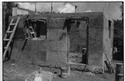
Casita construida con el método Sanut muro bloque, en el Ceder, Piedra Grande.
