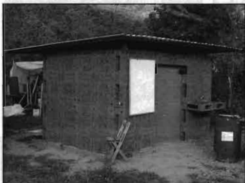
Bodeguita de materiales reciclados, Grupedsac-rrr. Fotografía de Juan Castillas.
