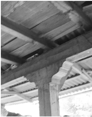
Figura 2. En esta construcción de Comachuén se observa una columna de concreto con detalle de capitel como si fuera de madera tallada.
