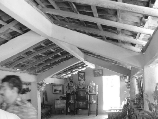
Figura 7. Los nuevos materiales, como el concreto armado, comúnmente se utilizan a la manera de los materiales tradicionales. Aquí se observan las traveses como si fueran vigas de madera
