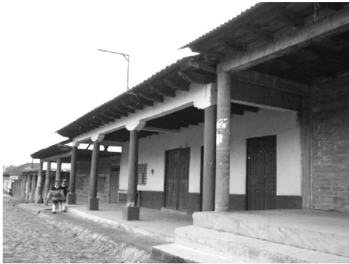
Figura 4. La falta de madera induce a la utilización del concreto a la manera del material tradicional, recreando formas tradicionales y espacios como portales y corredores.
