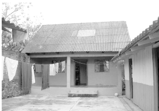
Figura 5. El uso de materiales como el concreto, el block de cemento y la lámina de zinc no impide las disposiciones y usos tradicionales en San Felipe de los Herreros.
