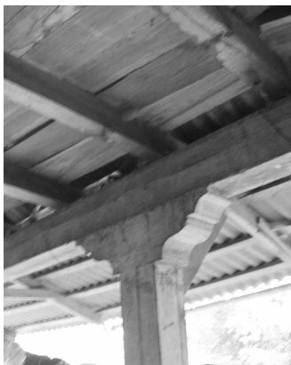
Figura 2. En esta construcción de Comachuén se observa una columna de concreto con detalle de capitel como si fuera de madera tallada.
