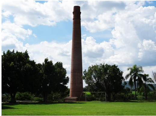
Chimenea o Chacuaco, Ex-Hacienda de Chinameca Morelos. Construcción asesorada por el fogonero de Cuernavaca, Felipe Neri en 1906.
