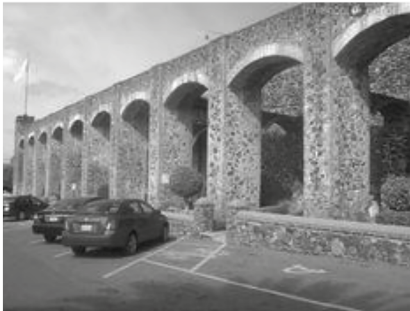
Acueducto de la hacienda de Juriquilla
