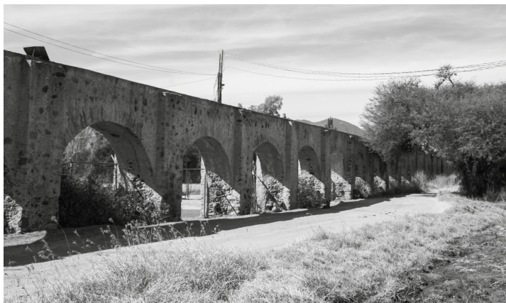
Acueducto que en el siglo XIX regaba las labores de la hacienda de Montenegro
